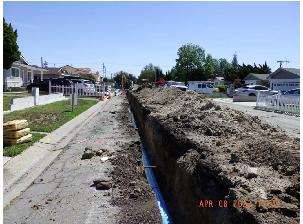
Thay thế Ống dẫn nước Chính Alwood Ave-Anthony Ave (4.200 foot dài)
